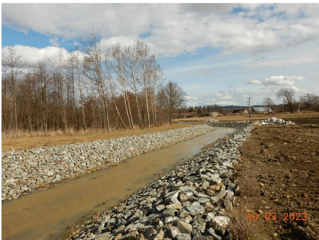
Fot.10. Wykonany narzut kamienny na skarpach nowego koryta Duny (poz. 45 PZŚ).
