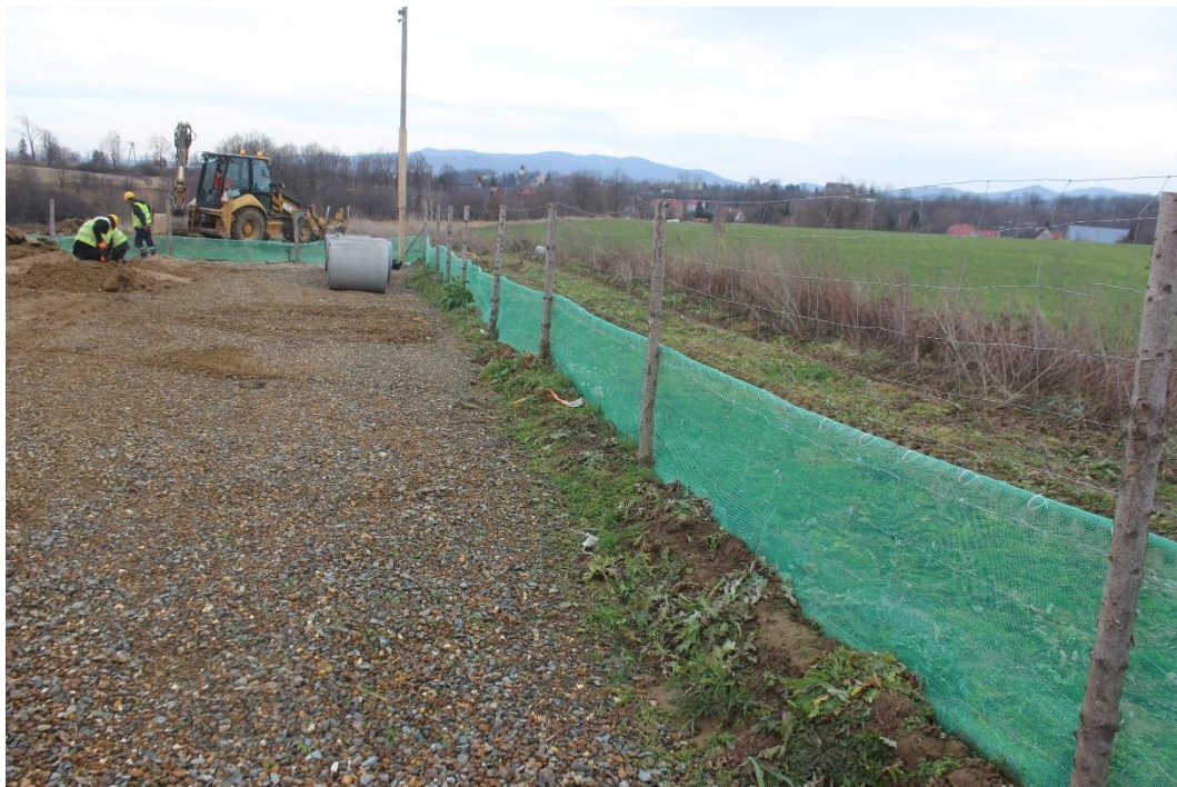
Fot.9. Zabezpieczenie zaplecza budowy przed przedostaniem się drobnych zwierząt (poz. 31 PZŚ).
